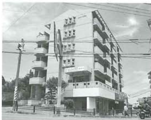
県道29号と34号が交差するところにあるRSN。周囲は住宅街
